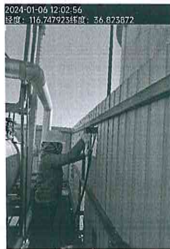
3#燃气轮机组排气筒
