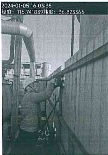
1#燃气轮机组排气筒
