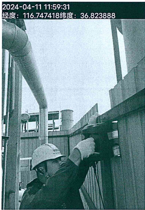
1#燃气轮机组排气筒 (DA001)
